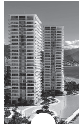
Condominios Peninsula Pto Vallarta , Cancún , Mazatlán Instalación Filtro Solar Mod. 4000 PhiFer
