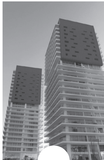
Central Park Qro. Instalación Filtro Solar Mod. 4000 PhiFer
