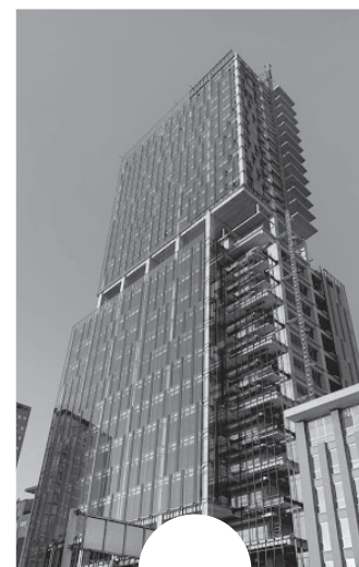
Torre Niba Guadalajara, Jal. Instalación Filtro Solar Mod. 2360 PhiFer charcoal grey
