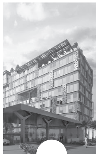
Vista Lomas Zapopan, Jal. Instalación Filtro Solar Mod. 4000 PhiFer Chalk
